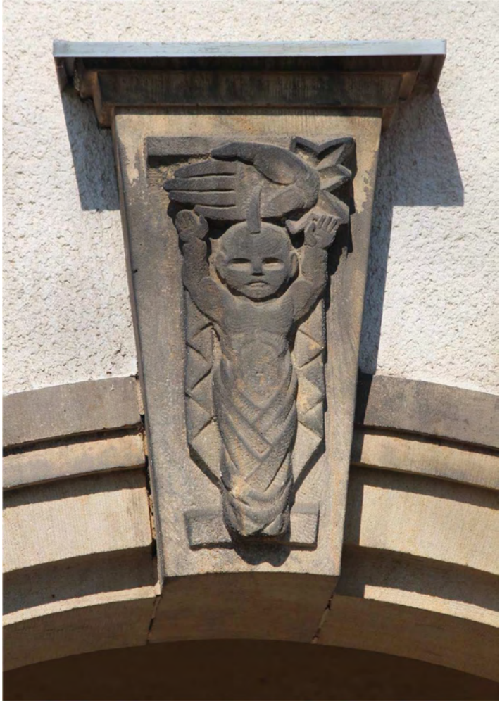
Detail Fassade Kirchengemeindehaus Böhlitz-Ehrenberg
